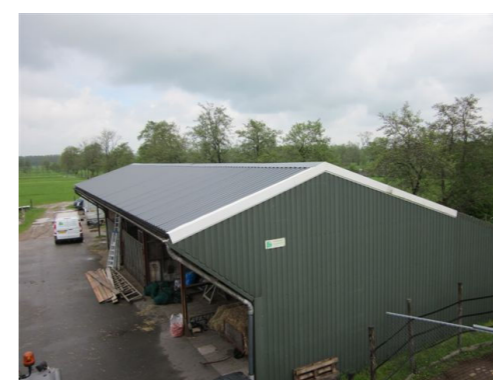
Geplaatst damwandplaten dak
