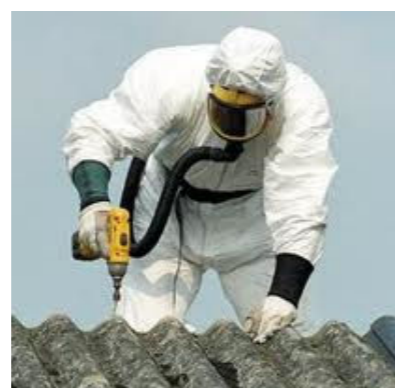
Demontage asbestplaten
